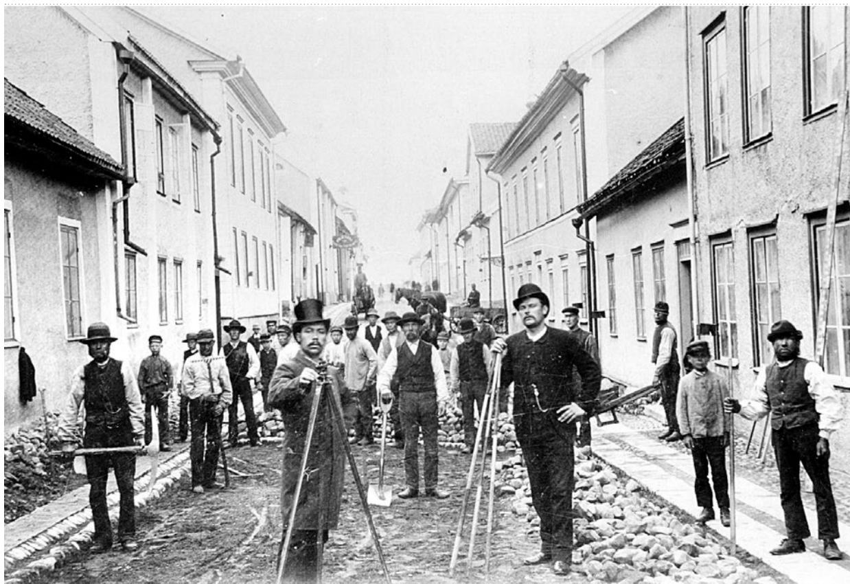
KYRKOGATAN. Gasledningsarbete eller nedläggning av vattenledningar, eller är det kanske bara stensättning av gatan? Bilden är från Mariestads bildarkiv och daterad 1888. Personerna på bilden är okända.
